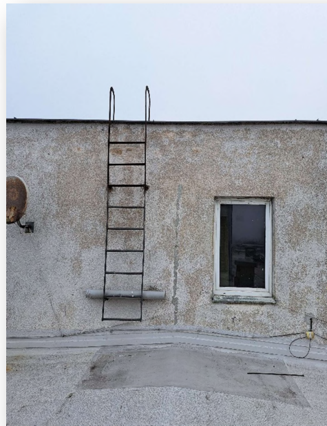
Wyjście na dach klatka druga.
